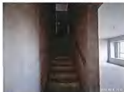
估价对象 4 室内状况
