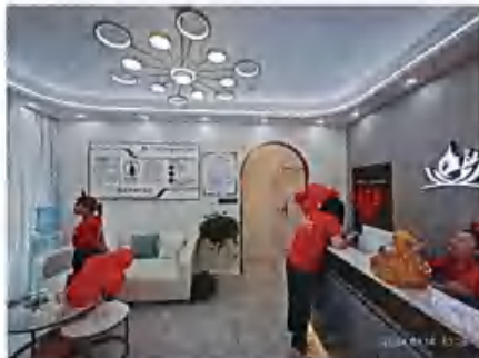
估价对象 1 室内状况
