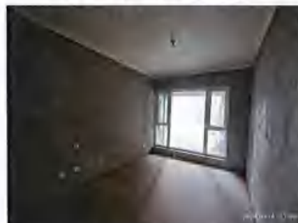
估价对象 4 室内状况
